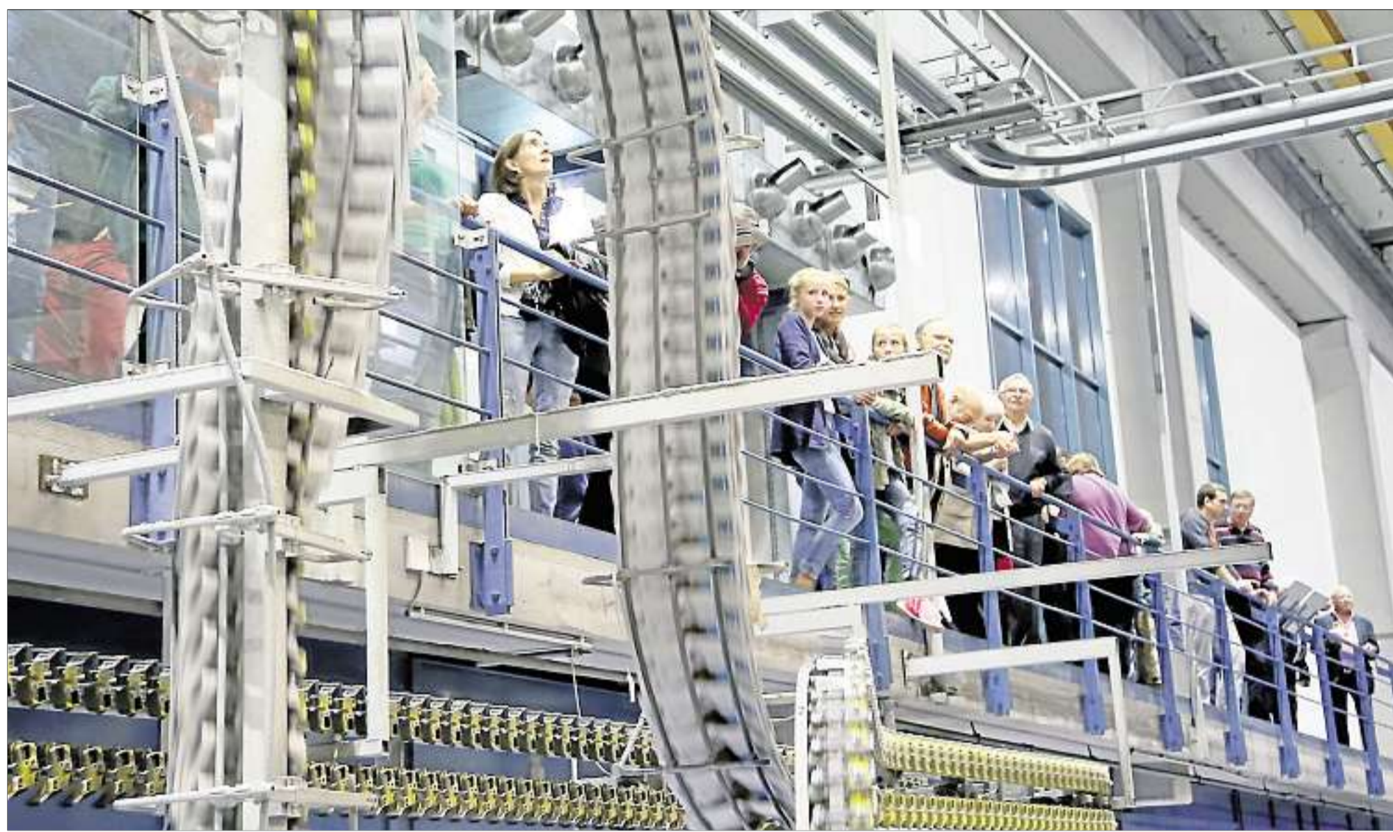
Live dabei sein konnte man, als am Abend die riesige Druckmaschine von Societäts-Druck in Mörfelden-Walldorf die fertigen Zeitungen über Förderbänder hinaustransportiert. Fotos: Spillner
